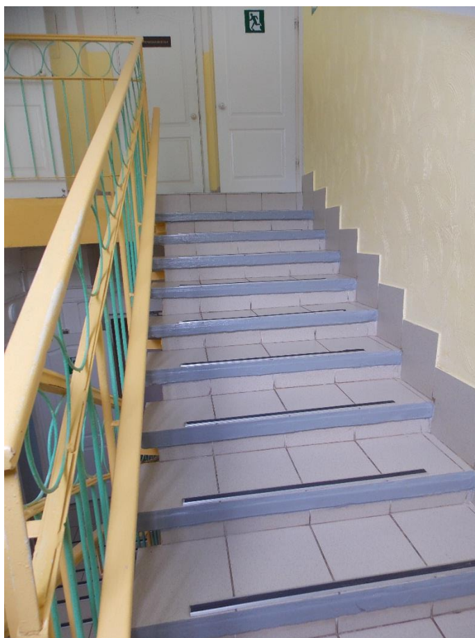
Фото 20. Лестничный марш (2-ой этаж)
