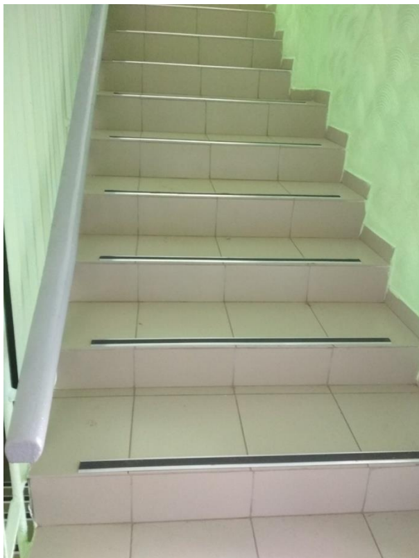
Фото 11. Лестница на второй этаж
